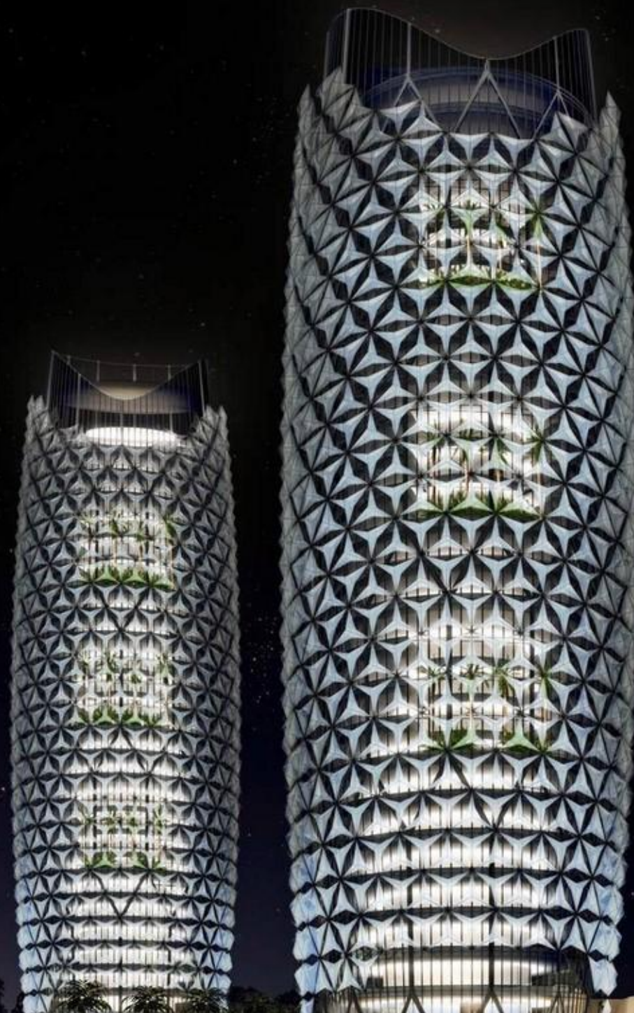
أبراج البحر في أبوظبي: مظلة شمسية تفتح وتغلق تلقائياً تتبعاً لحدة أشعة الشمس.
